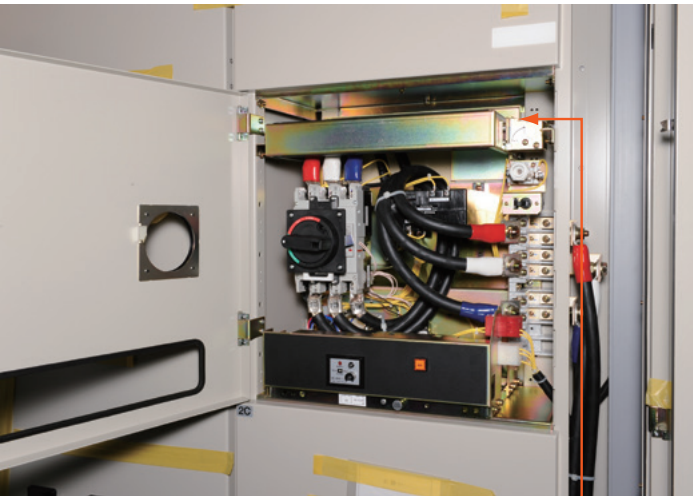
480mm以上のユニットの手動回転式のストッパ Manual rotating stopper for unit-devices larger than 480 mm
