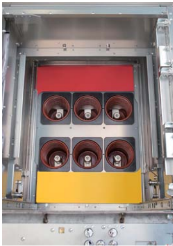
図3-4 シャッタ開状態(VCB) Fig. 3-4 Shutters open (VCB)
