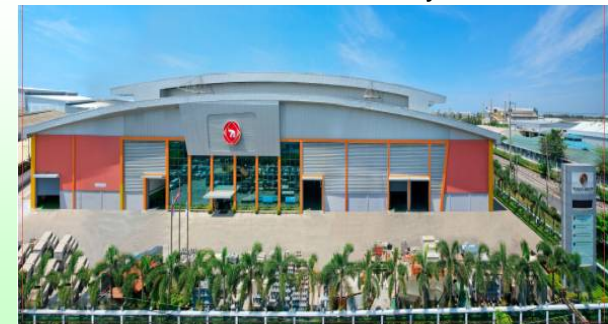
Tusco Trafo Factory
